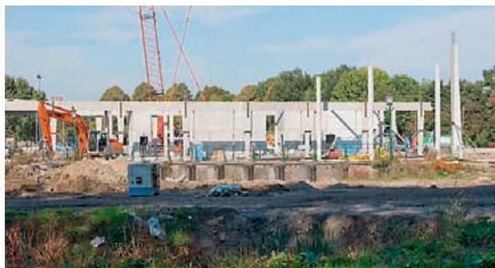
Op het midden van de foto, die aan het begin van de bouw is gemaakt, zijn pijlers zichtbaar van de brug met de twaalf gaten.
